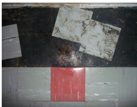
Abb. 4: Floorflex-Fliesen mit schwarzem Kleber
