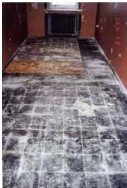
Abb. 3: Schwarzkleber unter Fußbodenbelag
